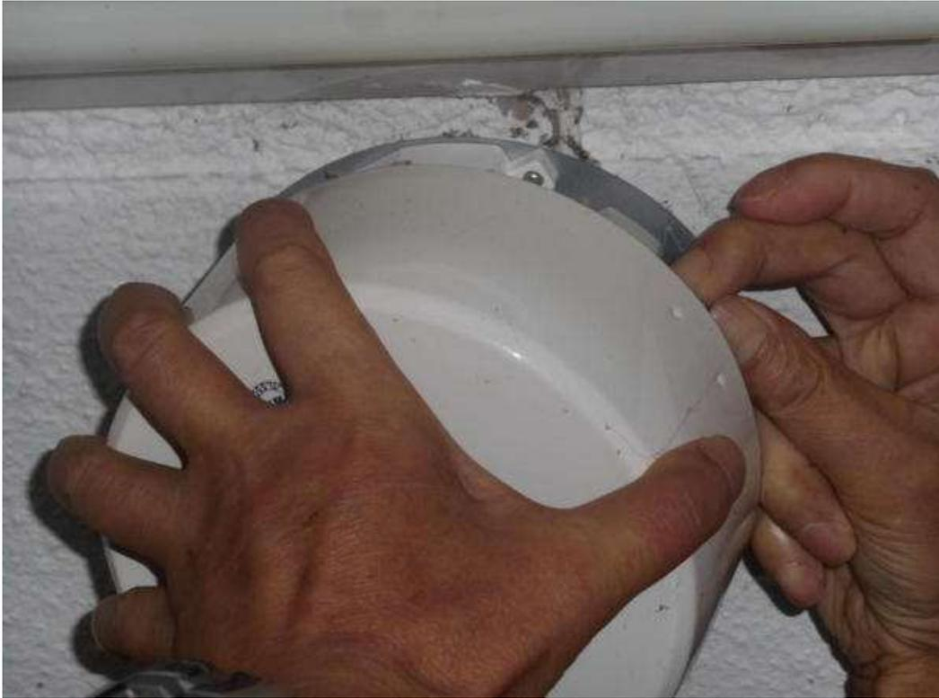
3. カバーを引き下げた隙間に指を入れて、バネを縮めてカバーとひっかり部からバネを外す (2ヶ所)
