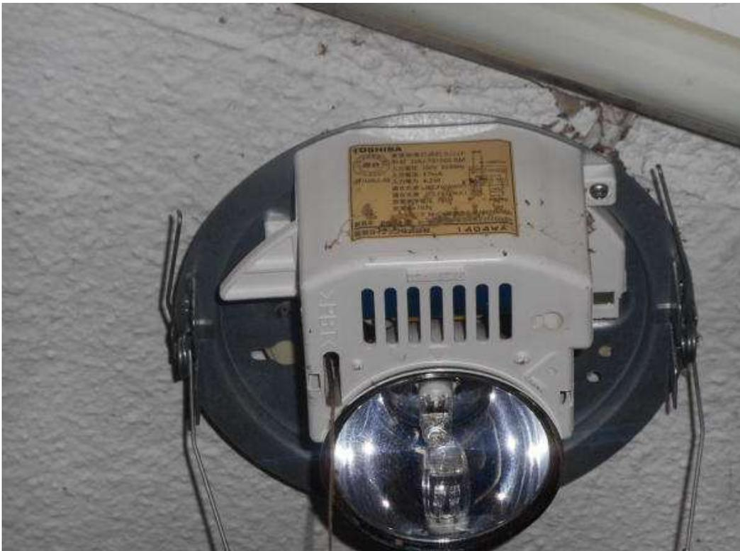
5. 新しいバッテリーを装着します。ヒモを引っ張って、ハロゲン灯が点灯することを確認します
