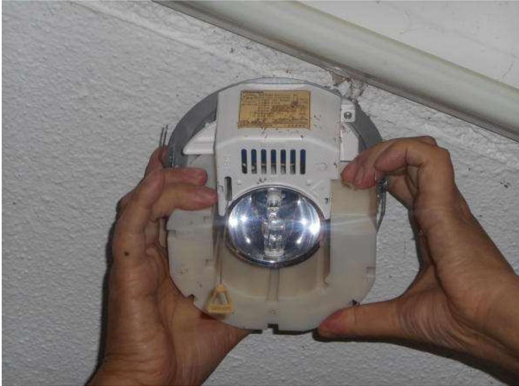
4. バッテリーは、「C字」型になっています。バッテリーだけを持って、C字の（部分方向に水平にスライドさせます
